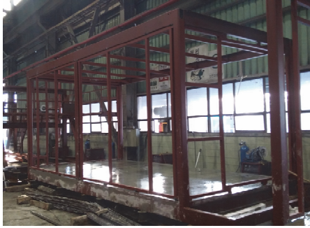
(a) With concrete slab (Kumkangkind co., Ltd)
