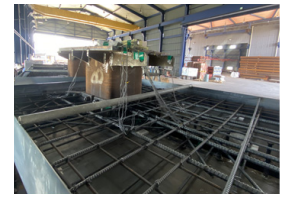
(d) Install steel formwork and place rebar
